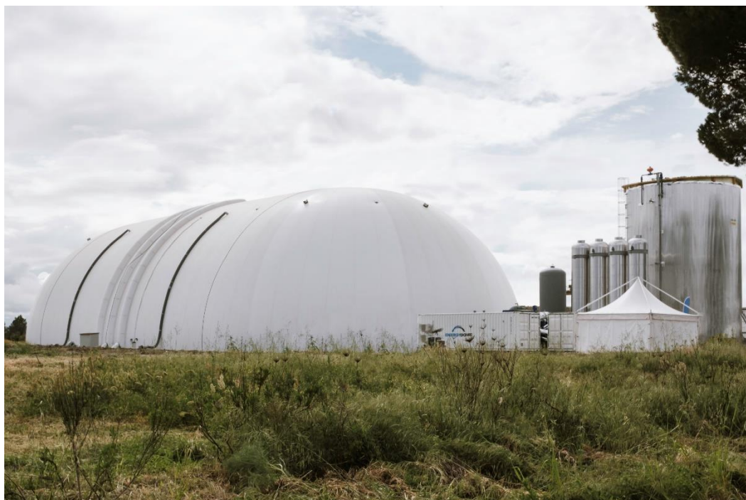
Figura 29 – Fotografia dell’impianto pilota CO2 Battery
