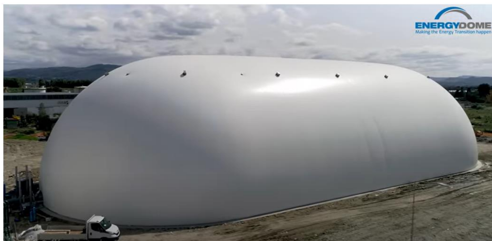
Figura 32 - Fotografia del gasometro installato nell'impianto pilota CO2 Battery
